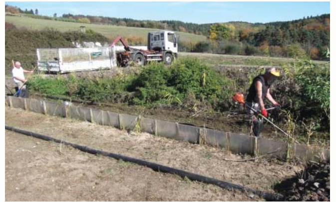
La station d'épuration de Malmont, de type plantée de roseaux, est très économe en termes de temps d'entretien et de process épuratoire. Il n'en demeure pas moins qu'une fois par an, les roseaux des bassins doivent être coupés et évacués pour un fonctionnement optimal de l'équipement.
