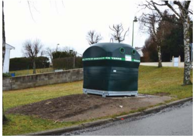
Afin d'accueillir dans de bonnes conditions la colonne de récupération de verres située au lotissement Côte-Vieille, une dalle a été installée.
